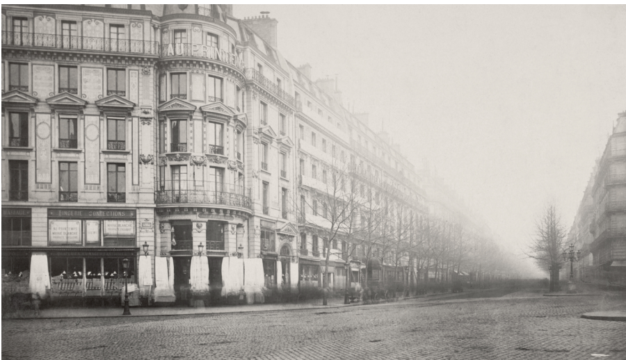
Figura 10. Rue du Havre . Uno de los bulevares creados por Haussmann
