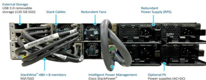
Imagen 24. Conexión Cables de Stack
