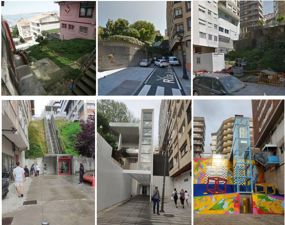
Figura 24. Antes y después de la instalación de los ascensores 1, 2 y 3.
