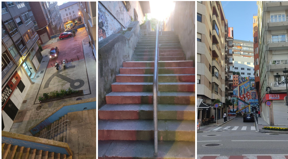
Figura 15. Fotografías de conexiones comunes entre los viales principales
