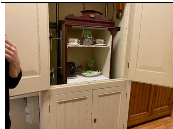
Fig. 5 Casa Amatller, detall del muntaplats, que puja des de la cuina a la planta baixa. Fotografia : Anna Viadel
