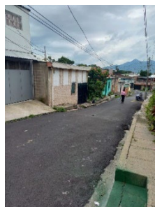
Fotografía 11: Aceras con desnivel y sin vegetación, invasión de acera
