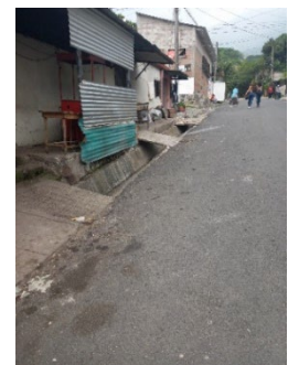
Fotografía 6: falta de aceras en calle principal
