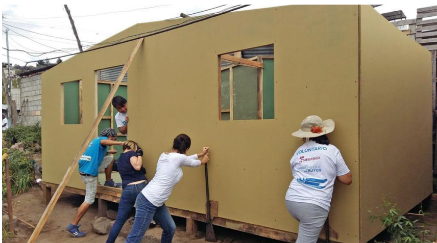
Imagen 4. Vivienda de paneles MDP.
