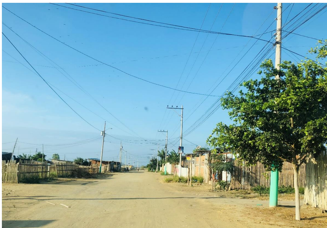
Imagen 29. Estado de las vías internas.
