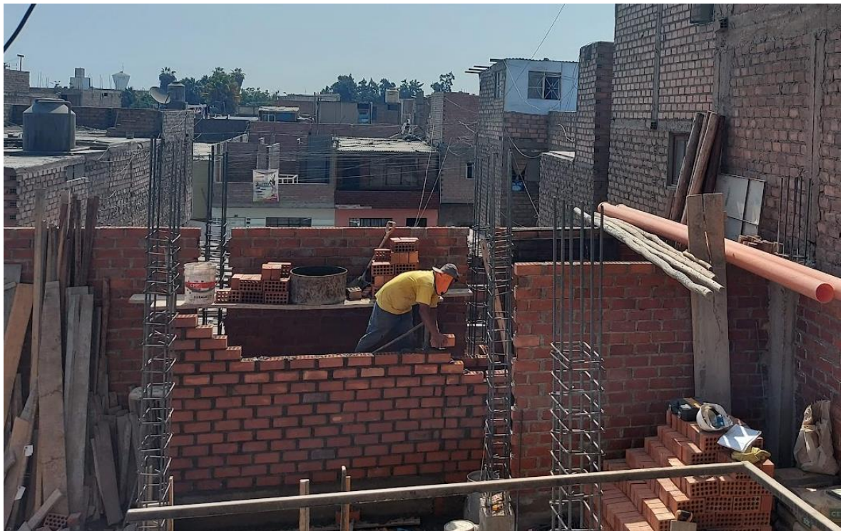
Figura 18: Etapa de levantamiento de muros, Proyecto Clorinda, en Comas, Lima Metropolitana.
