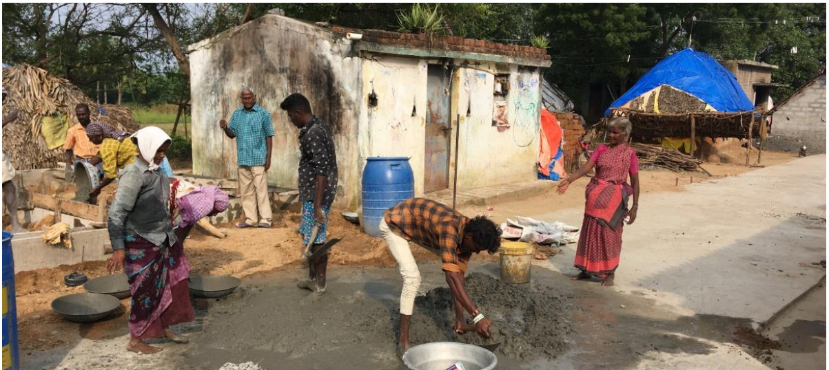
Figura 10: Mujeres participando en procesos de autoconstrucción en India.
