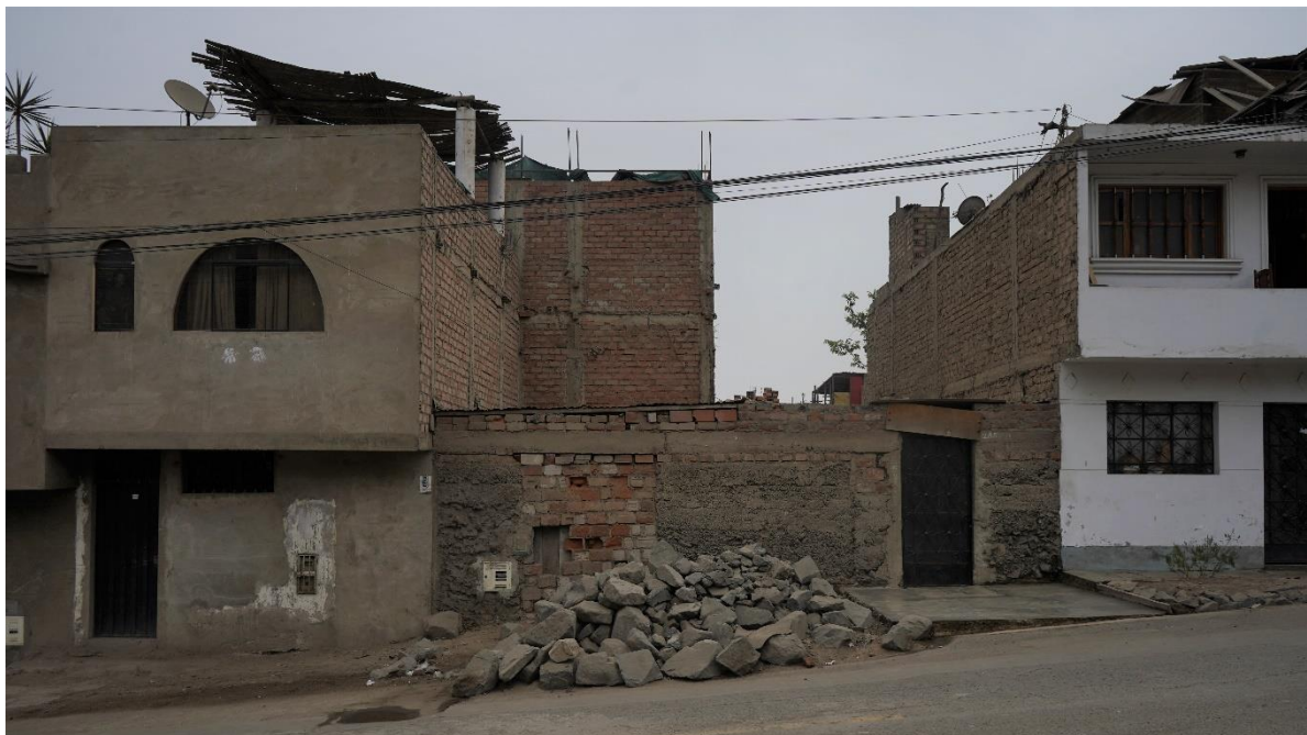
Figura 38: Viviendas de ladrillos y cemento, concreto armado en el Sector de La Flor.
