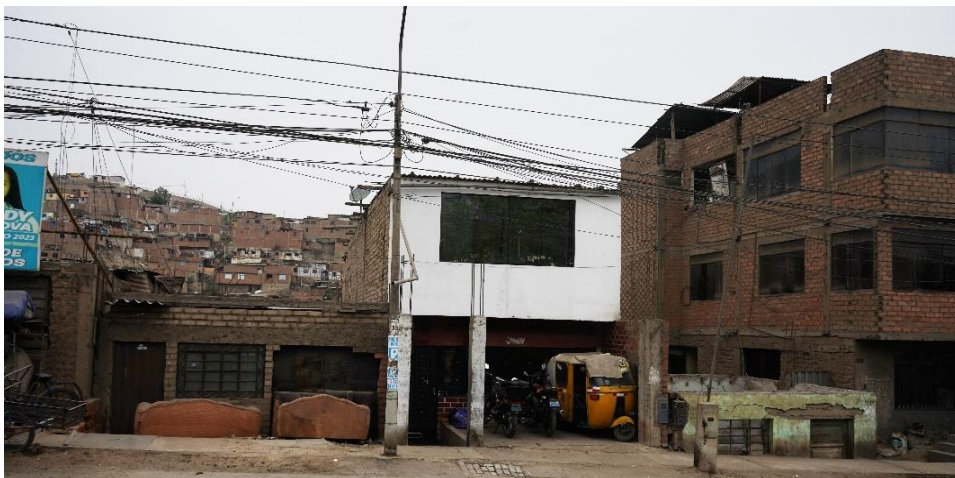
Figura 7: Viviendas autoconstruidas con potencial edificatorios en La Flor, Carabayllo, 2023.
