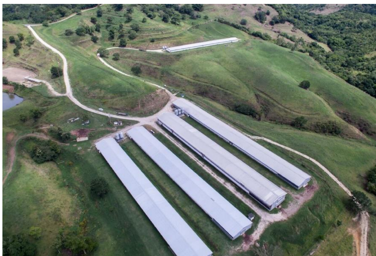
Figura 73. Galpón avícola tipo. Fuente. https://toricos.com/granjas/
