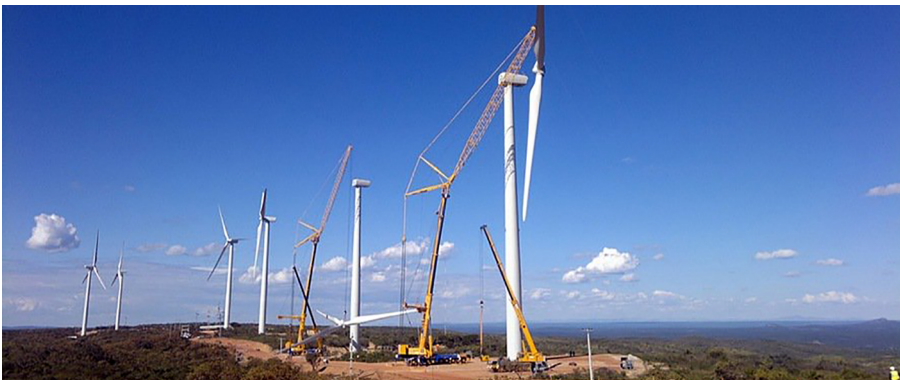
Figura 8. Detall del procés de muntatge d'uns aerogeneradors
