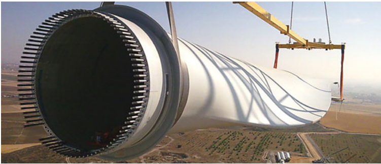
Figura 9. Detall del procés de muntatge de les pales
