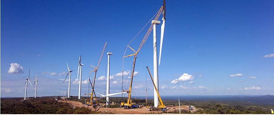
Figura 8. Detalle del proceso de montaje de unos aerogeneradores
