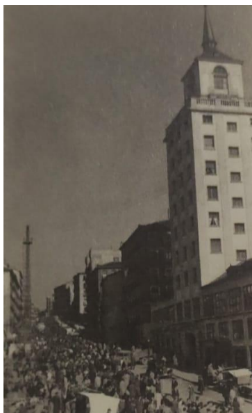
Figura 10: Torre de las Galerías Piquer, años 50 del s. XX
