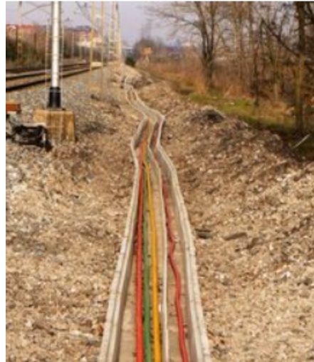
Figura 36. Tendido de Fibra Óptica en línea convencional de ADIF Renfe (Fuente[38])
