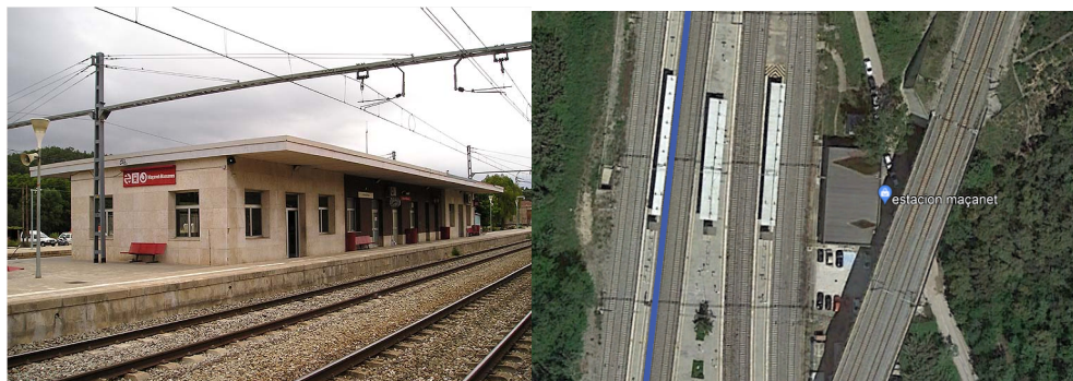
Figura 3. Estación de Maçanet- Massanes (Fuente:[4]).
