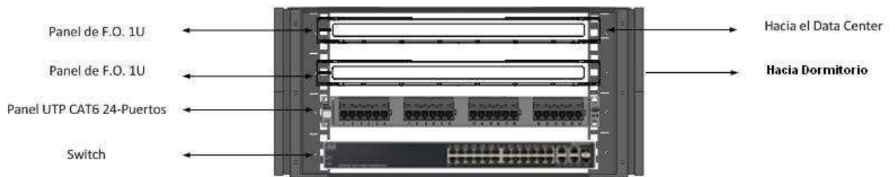
Figura 19. Armario Dormitorio Concentradores
