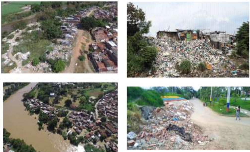
Imagen 7. Jarillón del río Cauca y Canal Interceptor sur, antes del reforzamiento
