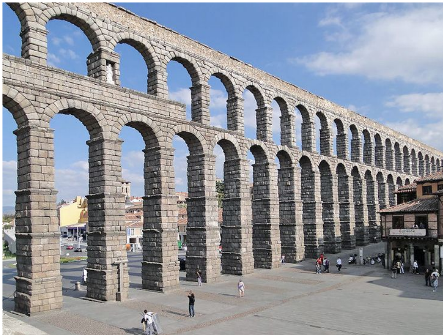
Fig. 1 Arcuationes del acueducto de Segovia.
