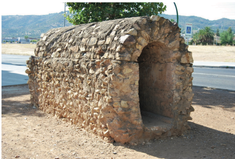
Fig 13 Tramo del specus del Aqua Augusta integrado en el paisaje urbano actual (Pizarro, 2012: 83)
