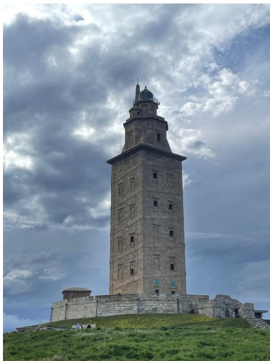
1. Vista de la Torre de Hércules
