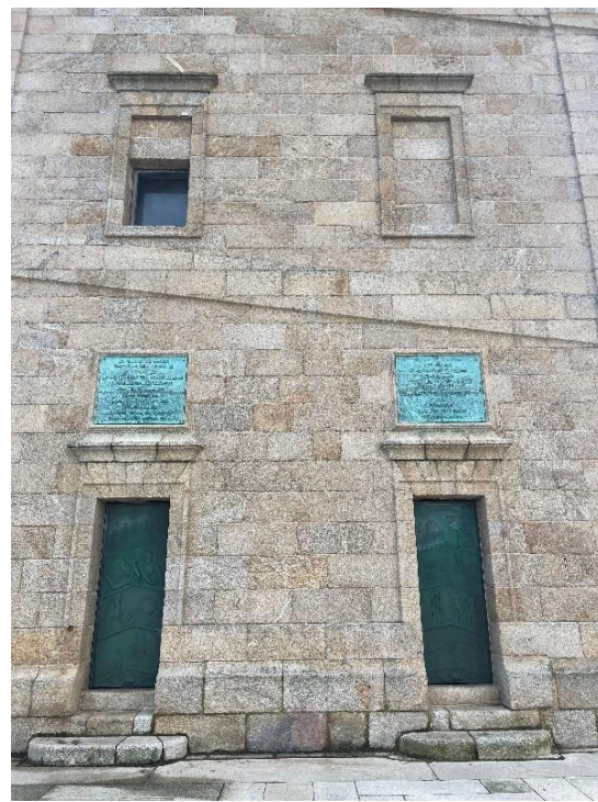
2. puertas de bronce de la Torre
