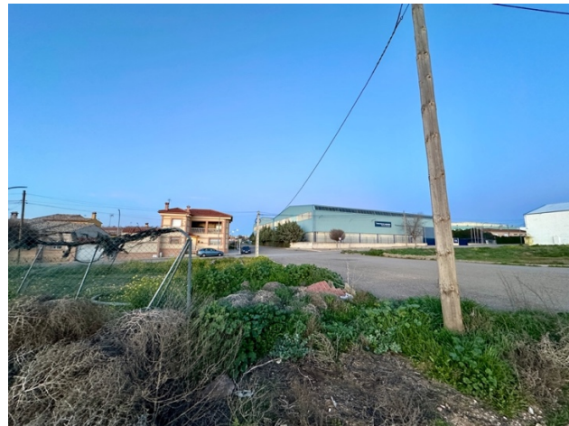
Figura 20. Fotografía IV: construcciones alrededor de la BTS existente. [elaboración propia]
