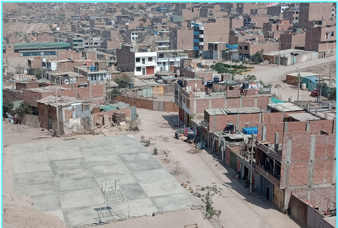
Imagen 27. Losa deportiva en Sector "La Fortaleza" - Manchay, Distrito de Pachacámac.
