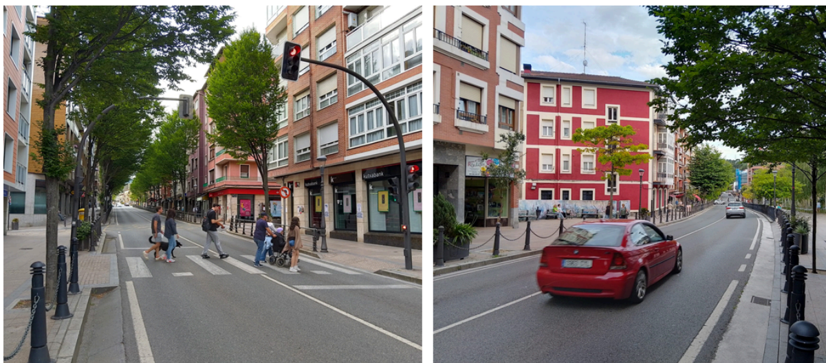
Figura 27. Dos fotografías de la avenida 1 de Mayo.
