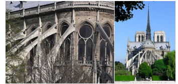
Detall dels arcbotants.
