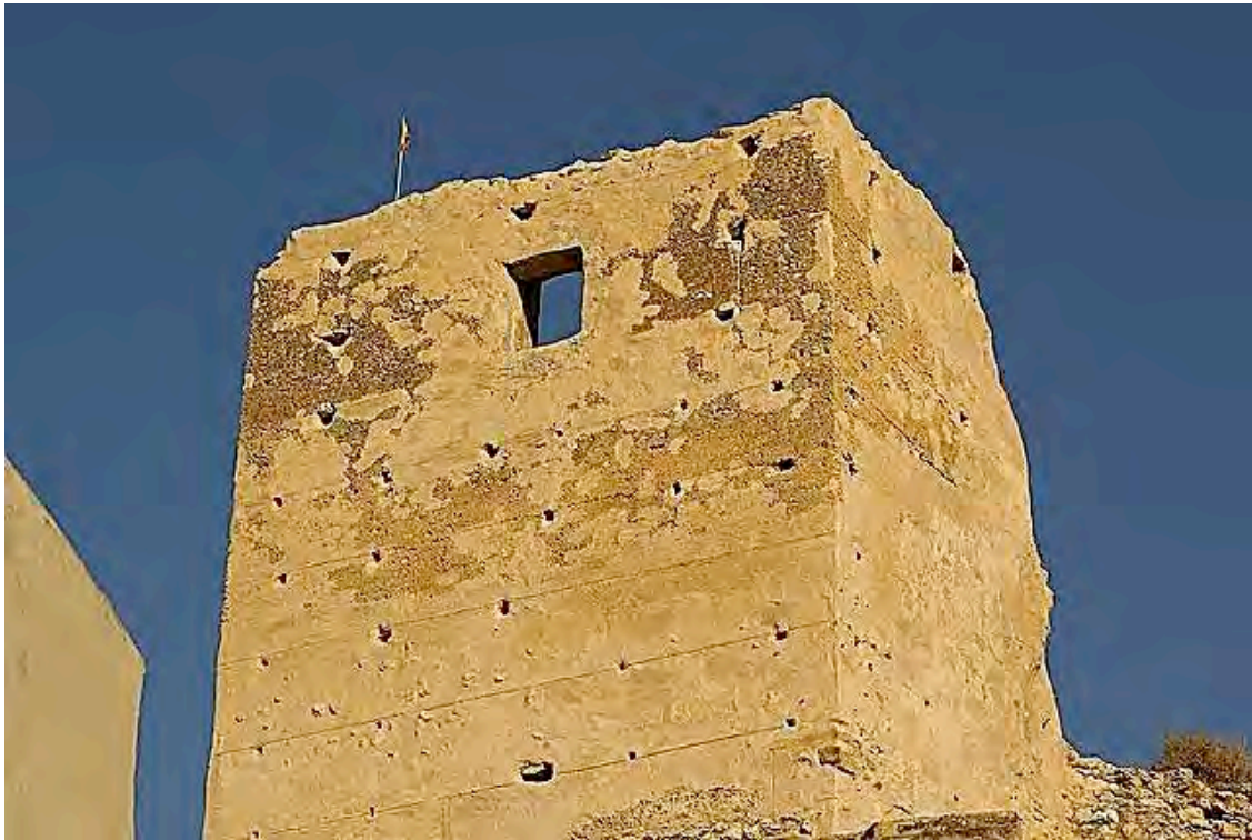
Lámina 16. Vista exterior de la torre cuadrangular. Fuente: http://bit.ly/1aL2ITM .
