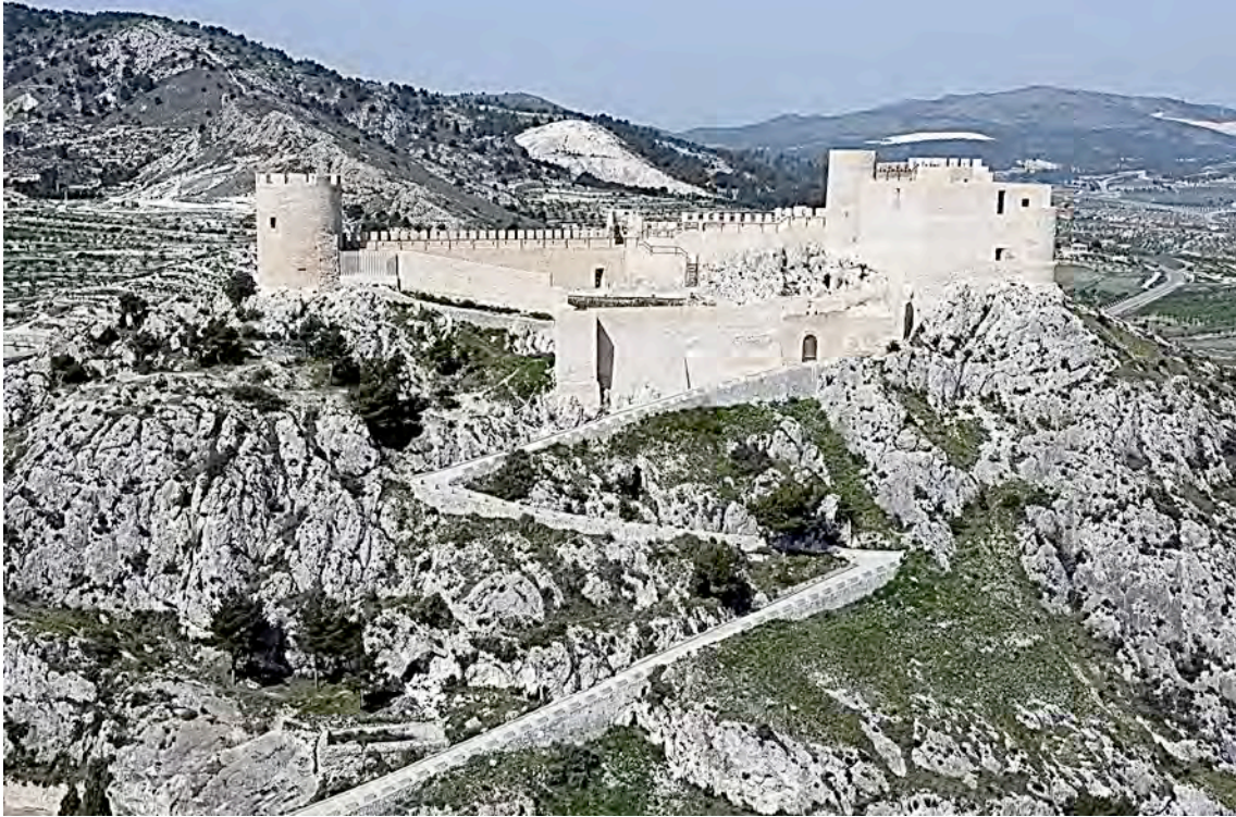
Lámina 6. Vista general del Castell de Castalla.
