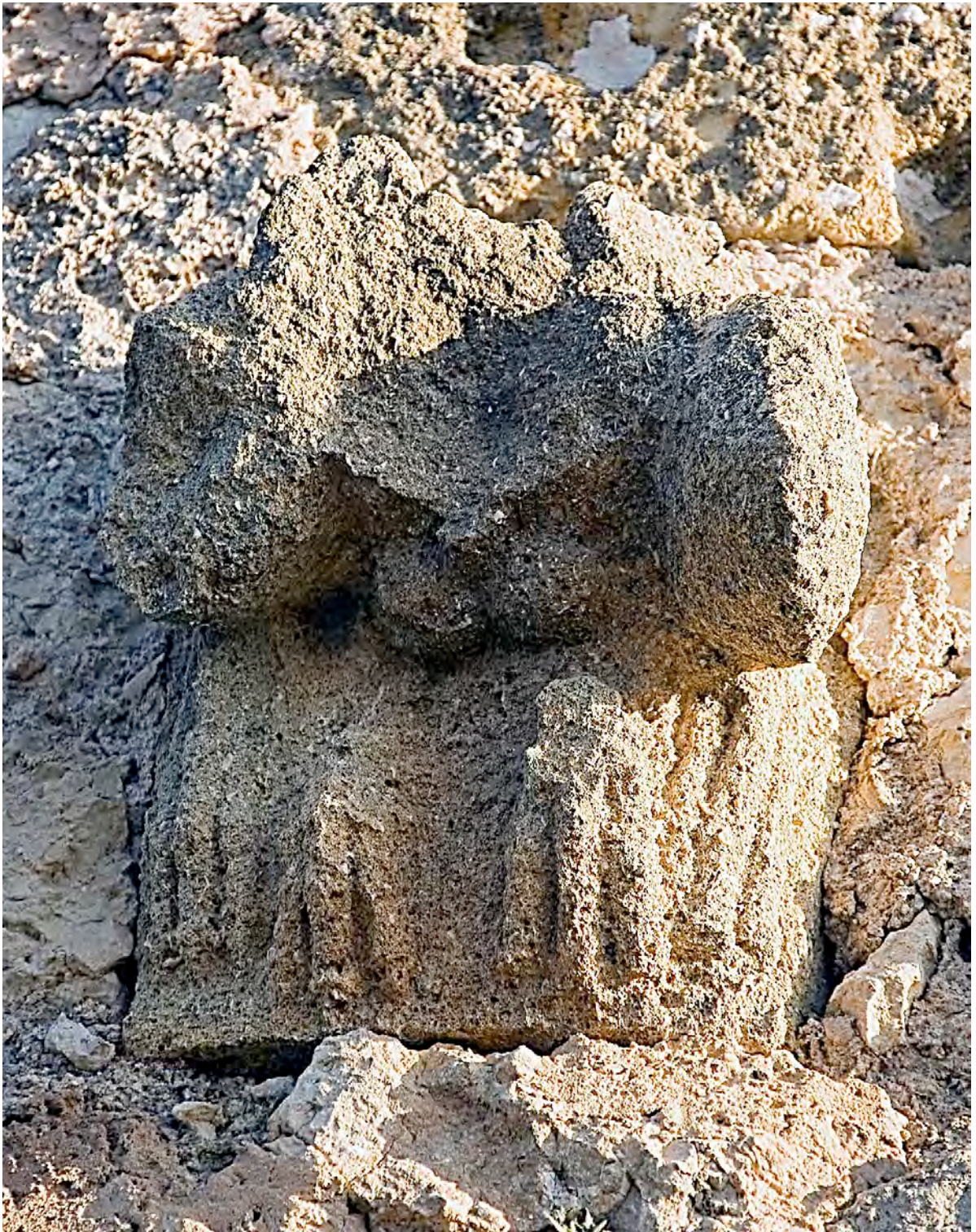
Lámina 9. Gárgola de la Torre Grossa.
