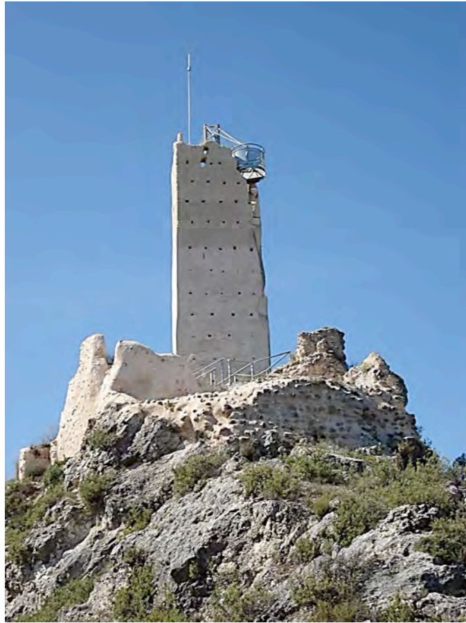
Lámina 18. Vista del Castell de Penella. Se observa, claramente, la escalera añadida a la torre tras la consolidación de la fortificación (2005). Fuente: ídem.
