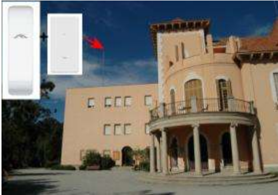
Imatge 49: Unió del CPE i AP de l'Alberg Torre Ametller
