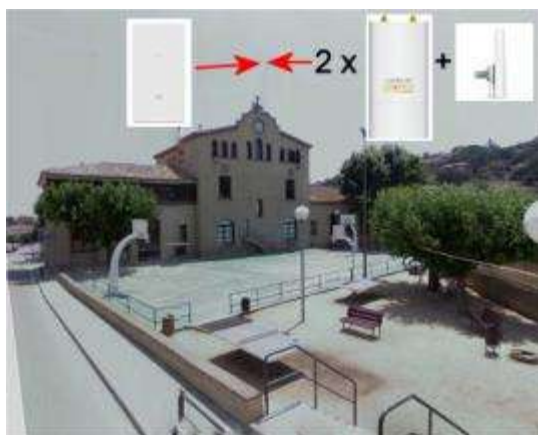
Imatge 25: Ubicació de estacions base i punt d'accés de la Casa de la Vila
