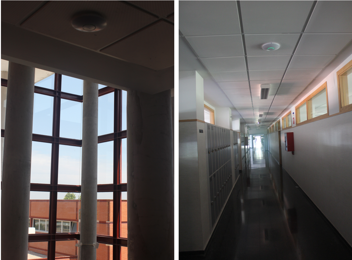
Instal·lació al corredor de la planta central i al hall amb connexió WDS amb el gimnàs
