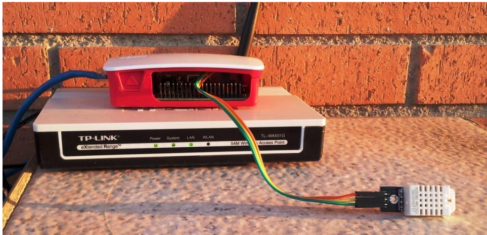
Figura 22.- Ubicació de proves del sensor al costat de la façana
