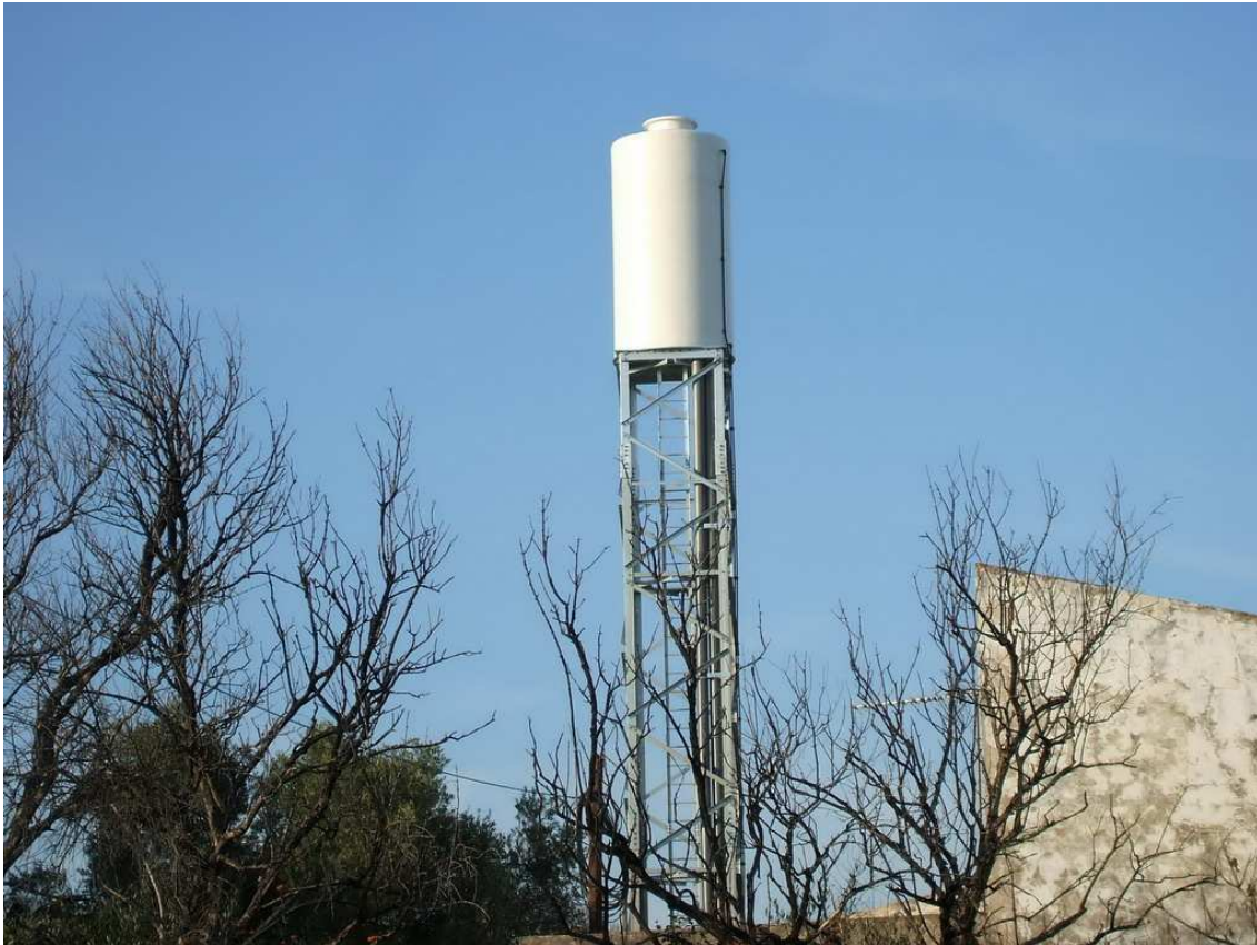
Figura 179. Mimetización tipo torre depósito de agua provincia de Cádiz. Foto real.
