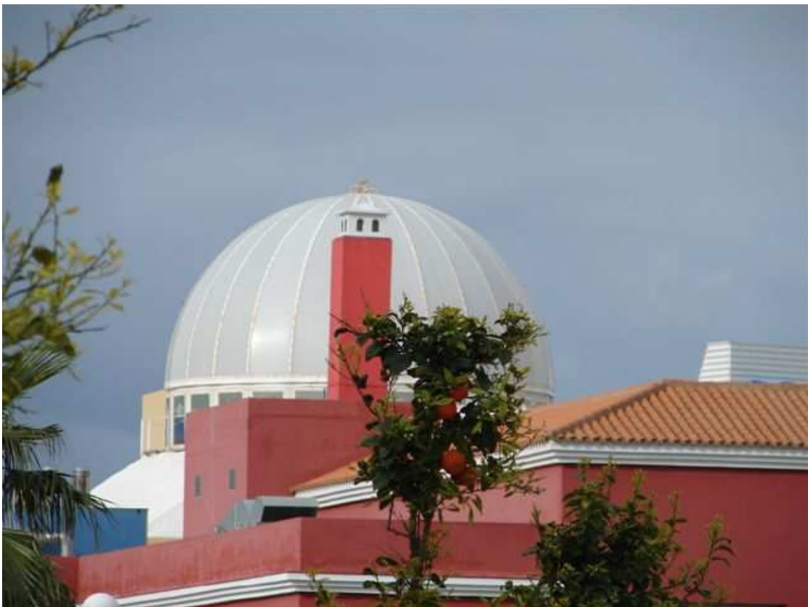
Figura 188. Mástil tipo chimenea en Hotel. Provincia de Cádiz. Foto real.
