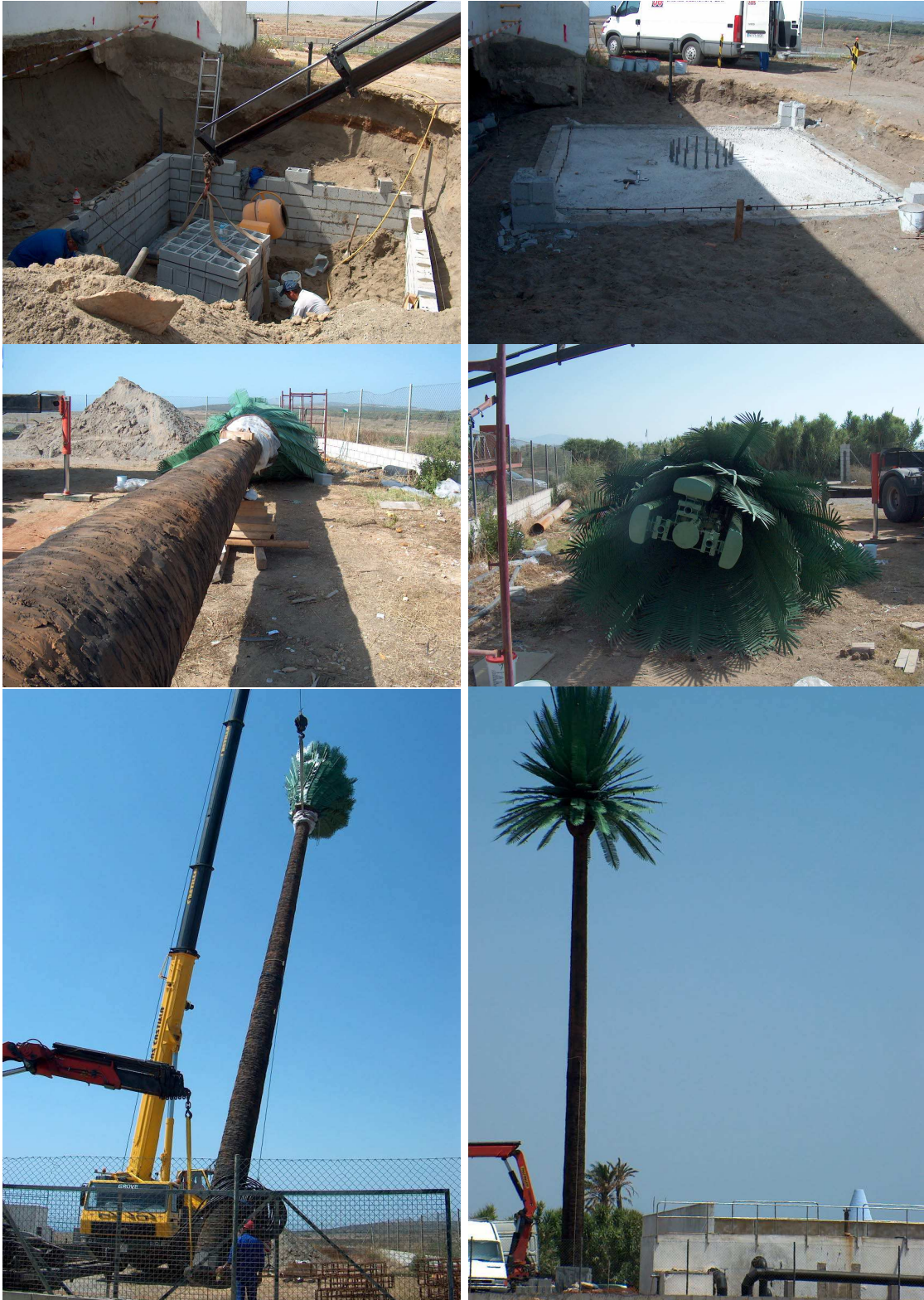
Figura 195. Proceso de construcción de torre palmera. Provincia de Cádiz. Foto real.
