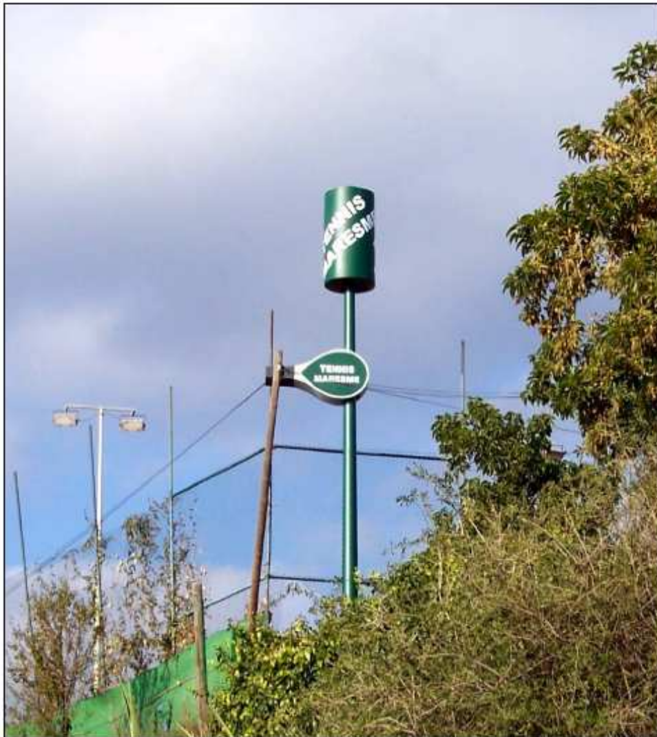
Figura 172. Antenas integradas en cilindro publicitario
