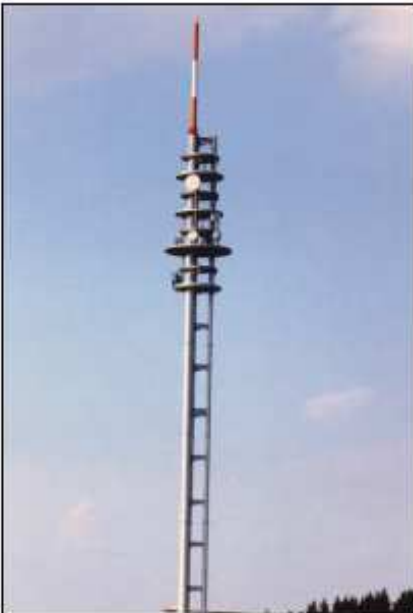
Figura 177. Estructuras triposte multi-operador y plataformas elípticas
