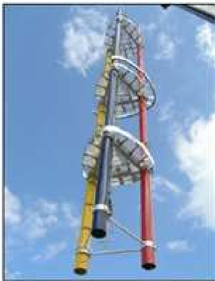
Figura 176. Torre de alta capacidad y estructura triposte de fibra de vidrio sobre tejado
