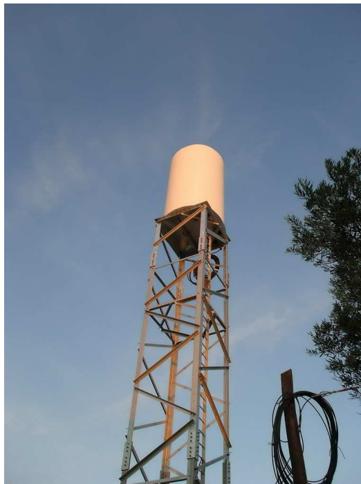
Figura 193. Torre tipo depósito de agua. Provincia de Cádiz. Foto real.
