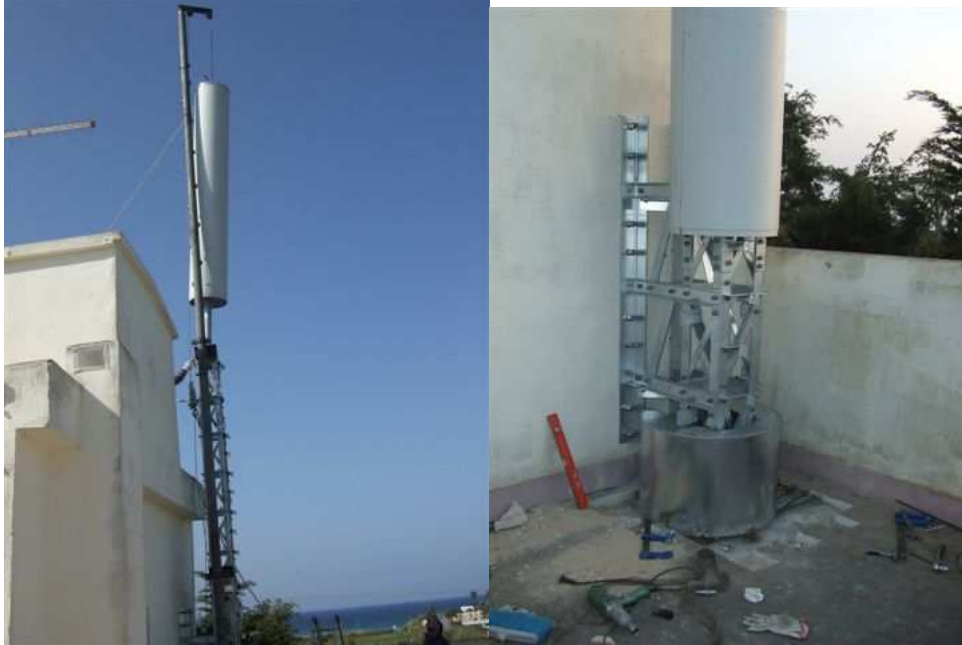
Figura 192. Construcción mástil trisectorial. Provincia de Cádiz. Foto real. Depósito de agua:
