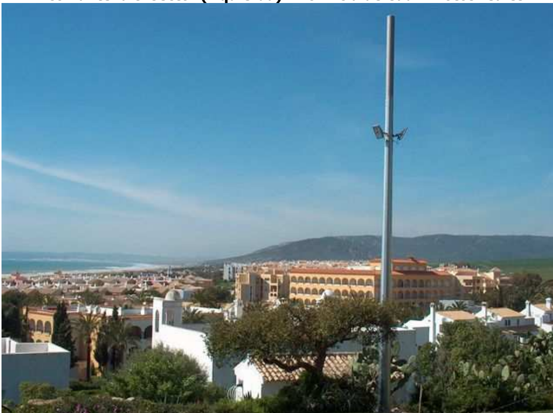
Figura 175. Antena trisector con iluminación. Provincia de Cádiz. Fotos reales.
