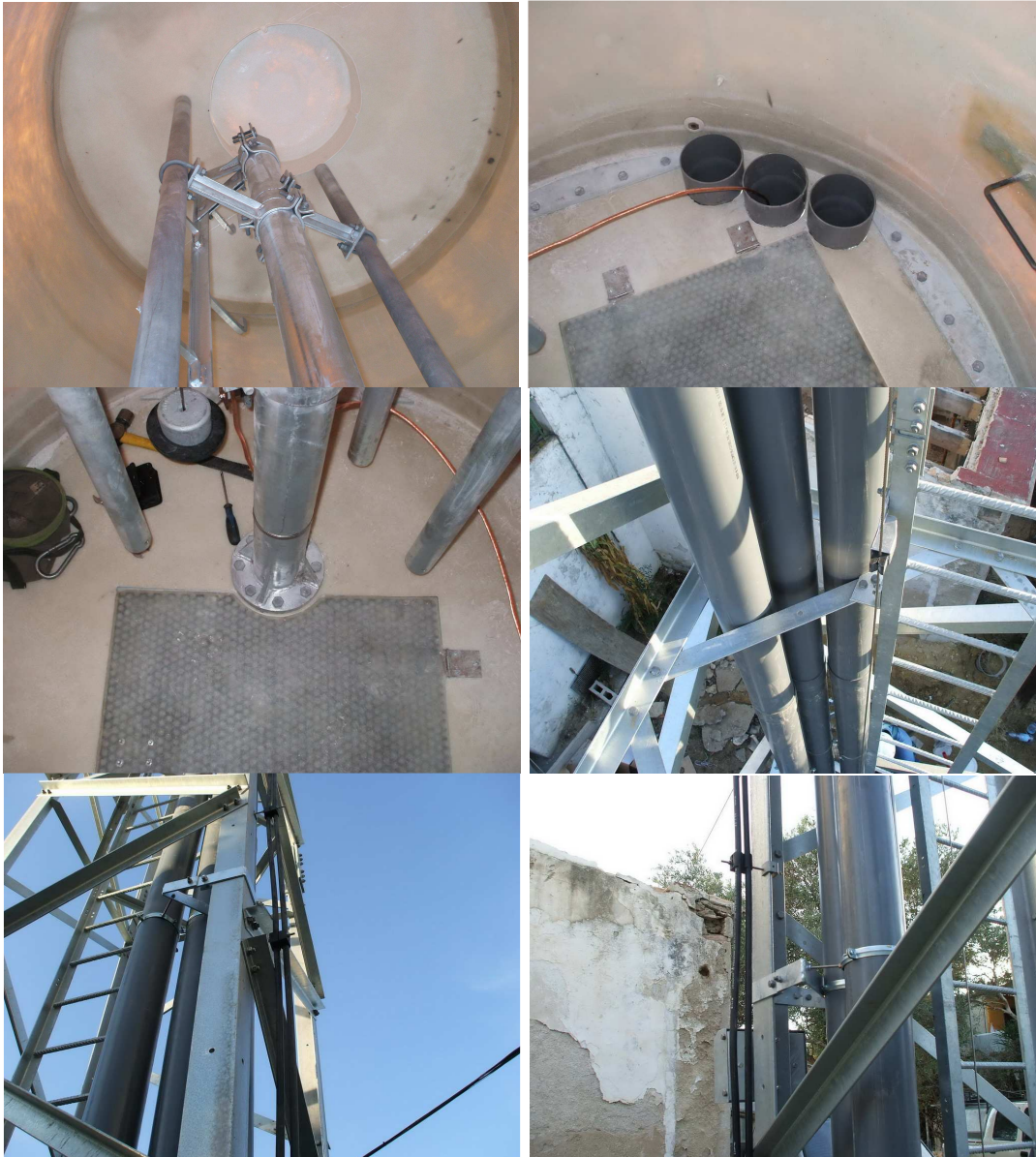
Figura 194. Detalle de estructura tipo depósito de agua. Provincia de Cádiz. Foto real.
