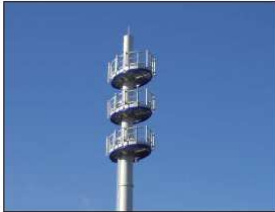
Figura 177. Estructuras triposte multi-operador y plataformas elípticas
