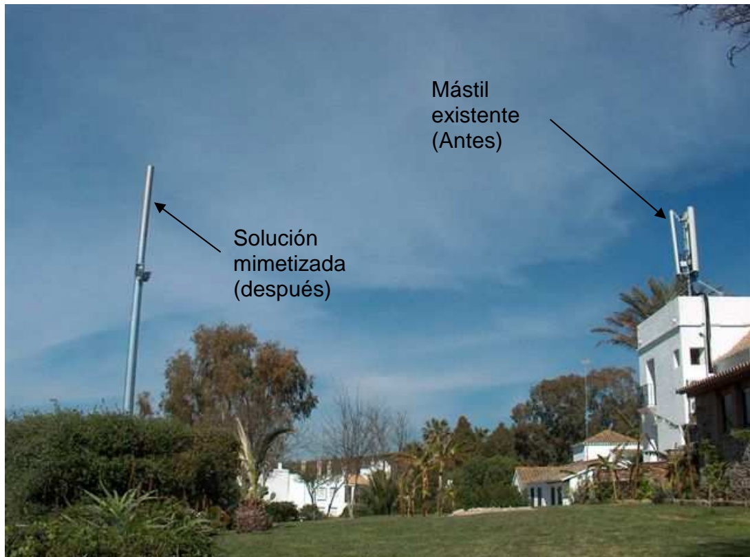
Figura 174. Comparativa mástil existente (derecha) y torre de iluminación con antena trisector (izquierda). Provincia de Cádiz. Fotos reales
