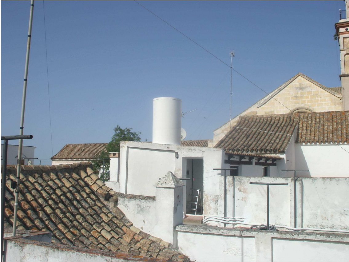
Figura 190. Sistema radiante en el interior de depósito de agua. Provincia de Cádiz. Foto real.
