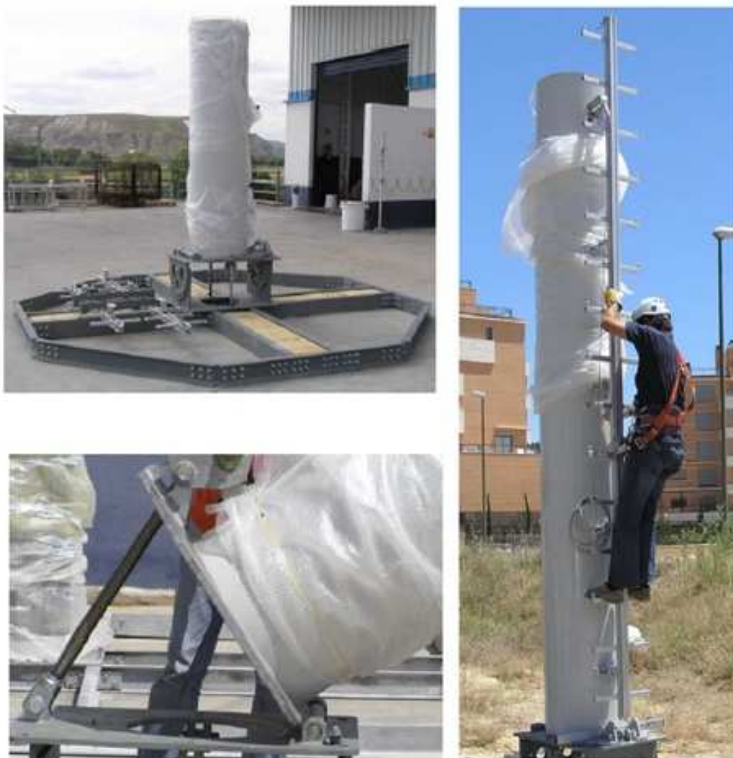
Figura 181. Antena trisectorial autosoportada con placa abatible
