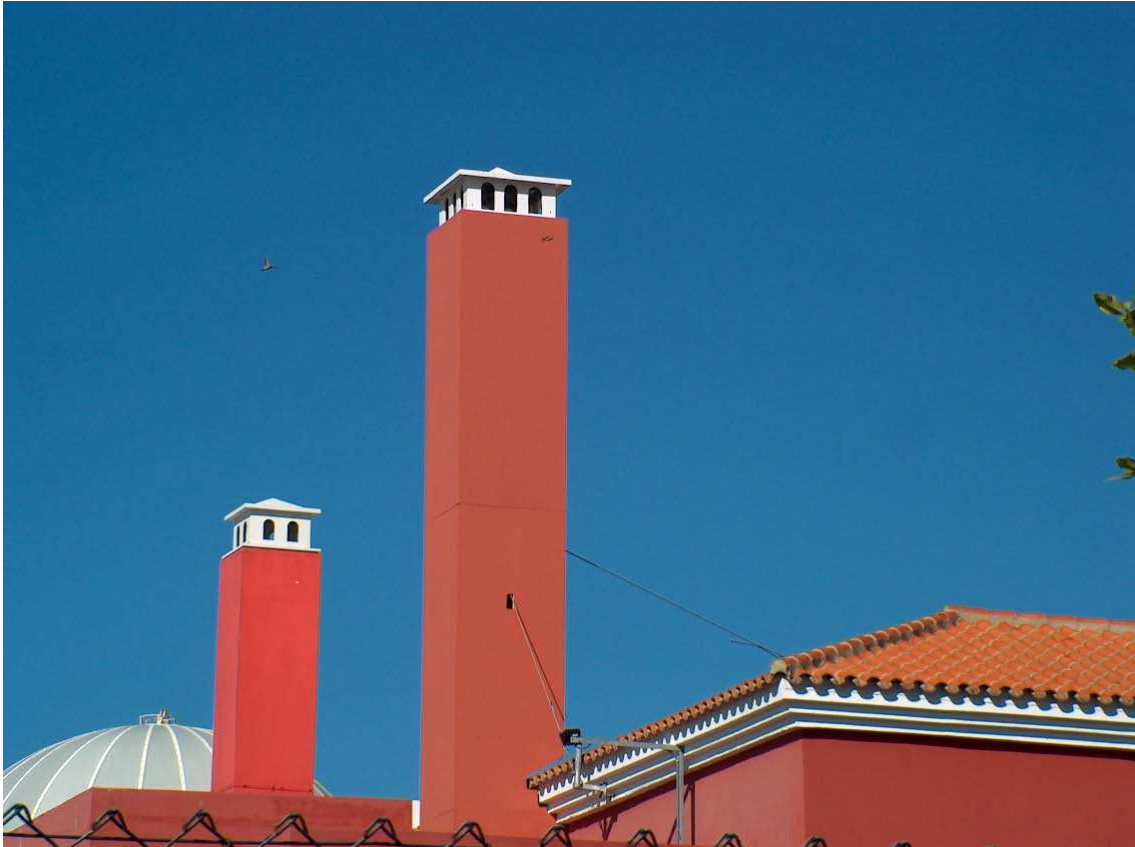
Figura 187. Comparativa chimenea real (izquierda) y mimetización sistema radiante (derecha). Provincia de Cádiz. Foto real.
