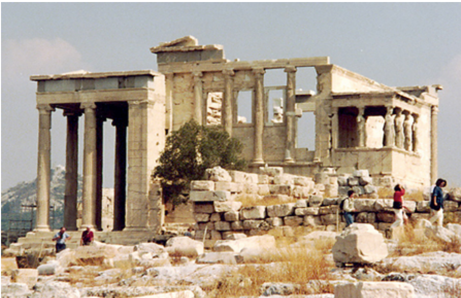
Vista de l'Erectéion
