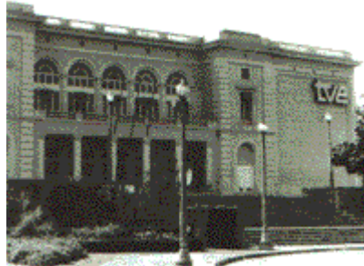
Edificio de TVE del paseo de La Habana
