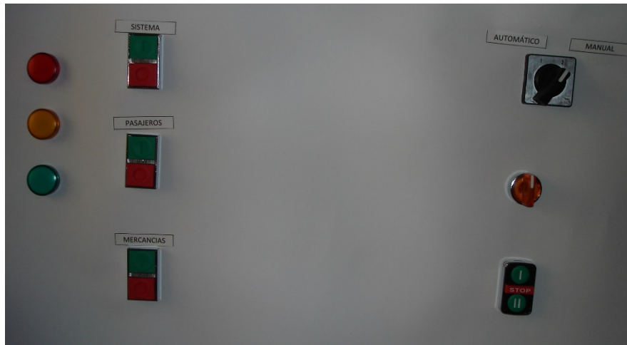
Figura 31. Interruptores de control
