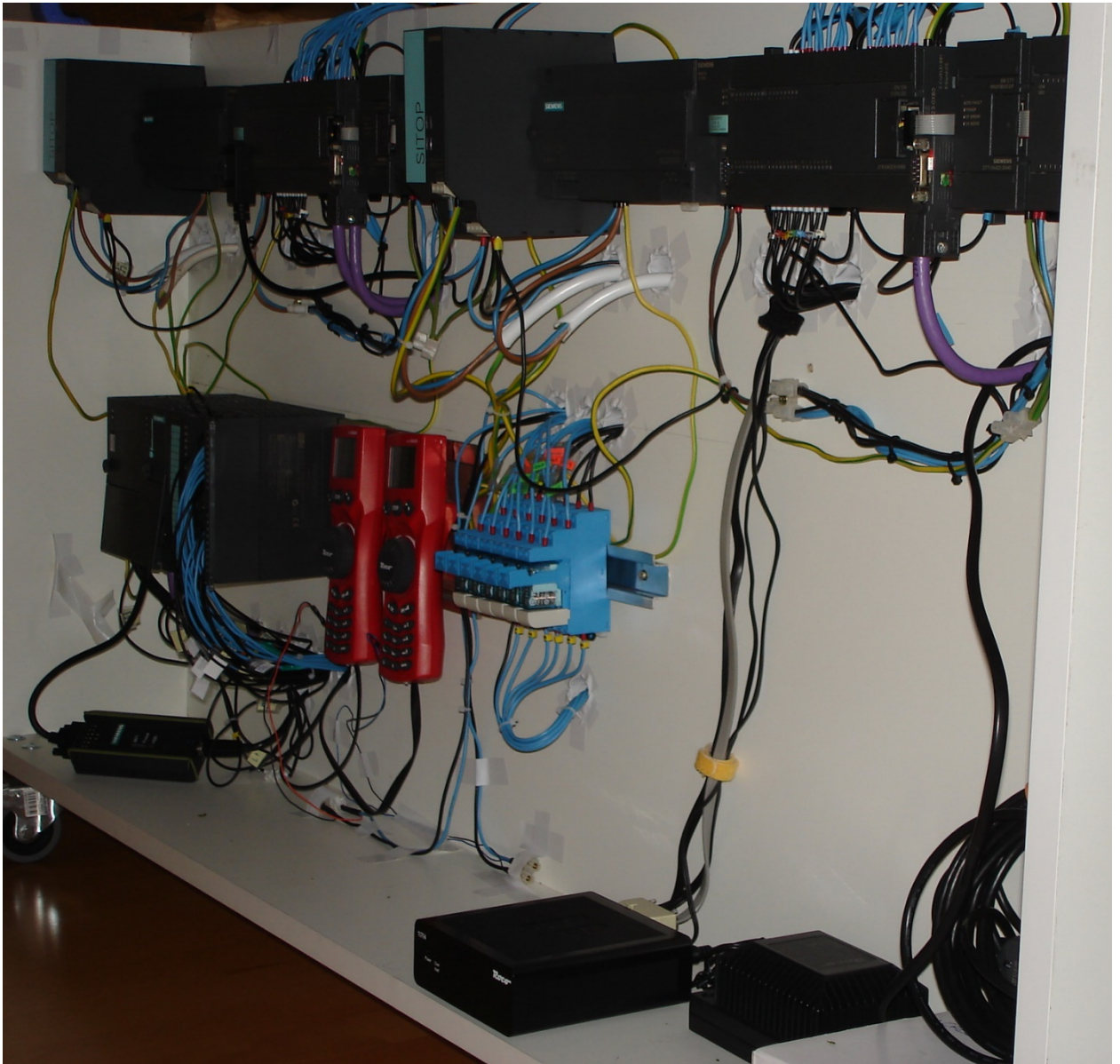
Figura 30. Cableado de autómatas
