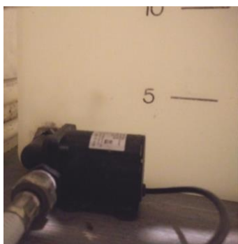
Figura 19. Bomba d'aigua instal·lada
