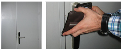
Ilustración 5-20. Control de acceso a salas mediante tarjeta RF
