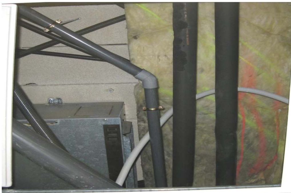
Ilustración 5-37. Detalle tuberías de desagüe
