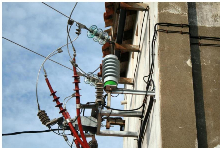
Figura 8 Ejemplo de instalación del CAMS-10/C en línea aérea
