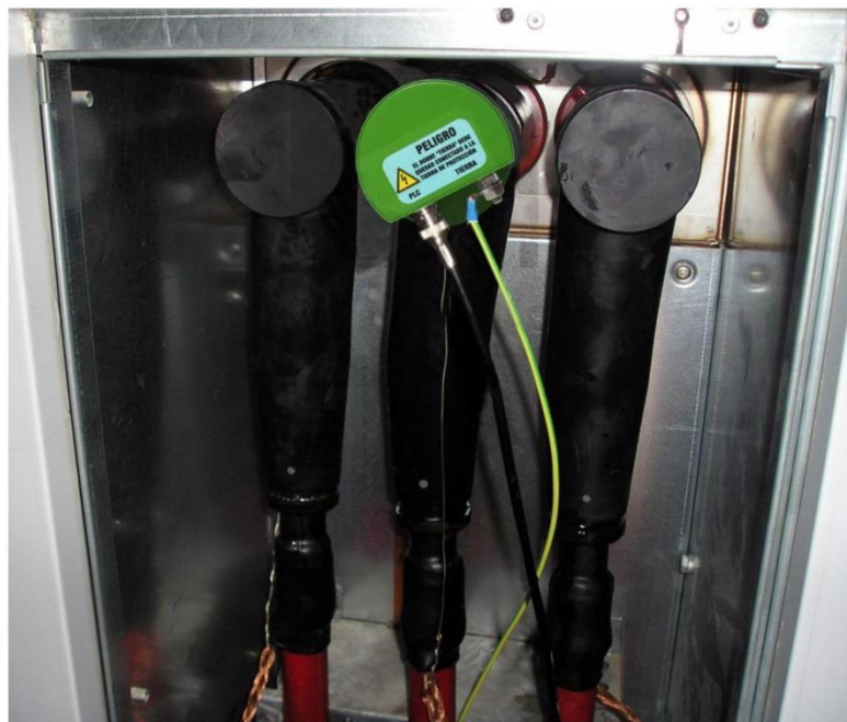
Figura 8 Ejemplo de instalación del acoplamiento ACA-500
