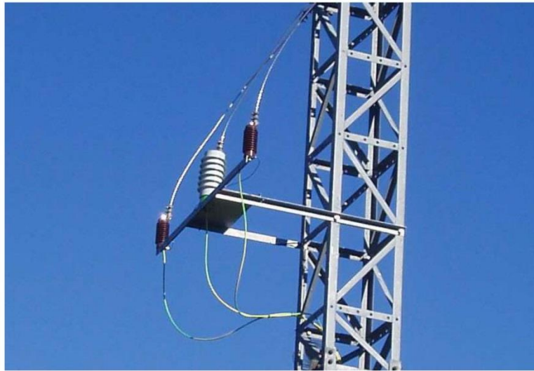
Figura 7 Ejemplo de sujeción mediante un herraje unido a la torre eléctrica
