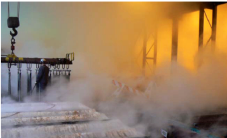
Figura 5. Emisión de nieblas en la sala de celdas en el mes de febrero, con las cortinas totalmente cerradas
