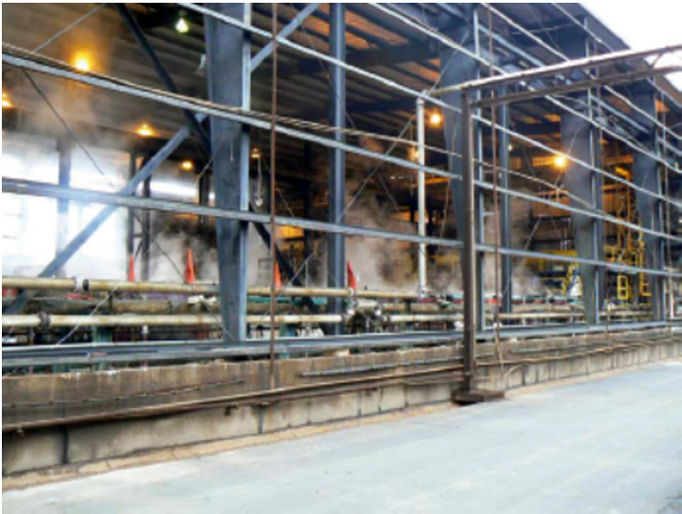
Figura 2. Sala de celdas con la pared lateral abierta, en época de verano
