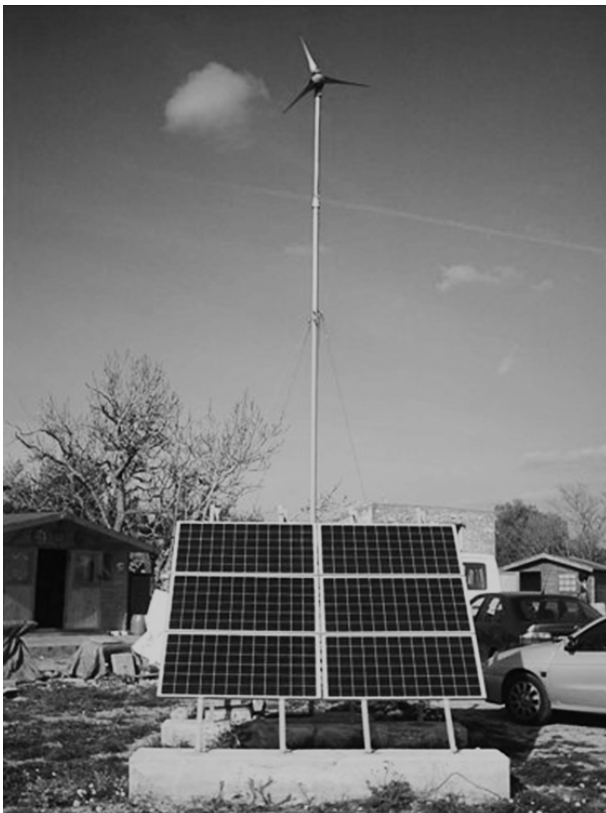
Figura 59. Sistema d'electrificació rural híbrid: eòlica i solar
