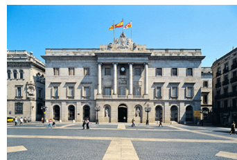
Façana de l'Ajuntament de Barcelona
