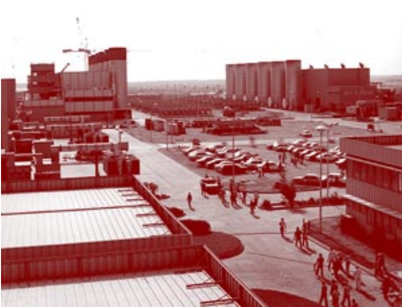
Central térmica de gas en Arabia Saudí
