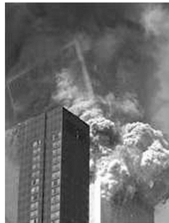
Esfondrament d'una de les Torres Bessones.
