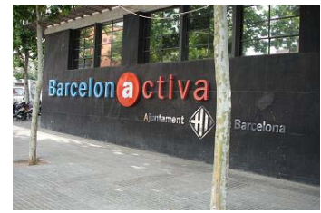
Antigues fàbriques industrials s'han rehabilitat i s'han reutilitzat com a infraestructures per al desenvolupament local.
