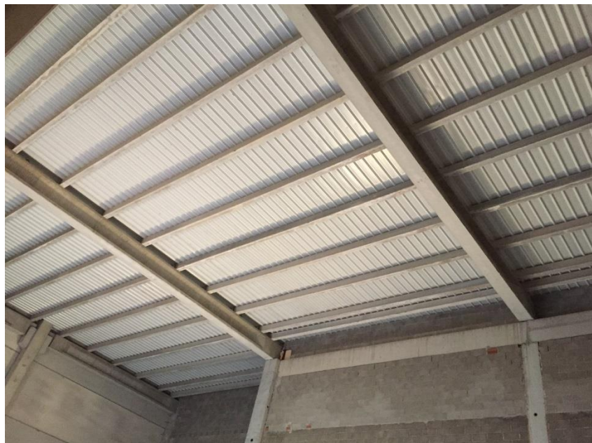
Il·lustració 15: Fotografia interior del sostre de l'espai polivalent
