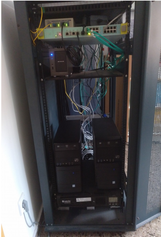
Figura 73: RACK principal per davant amb MCL amb Proxmox
