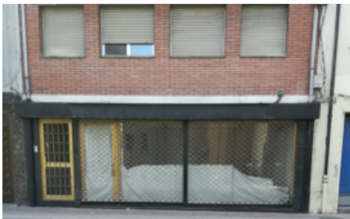
Figura 1: Façana actual de la futura oficina.
